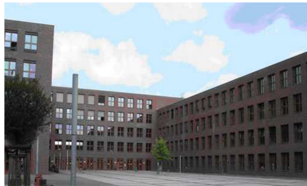
Schulgebäude der Wilhelm – Ostwald – Schule
